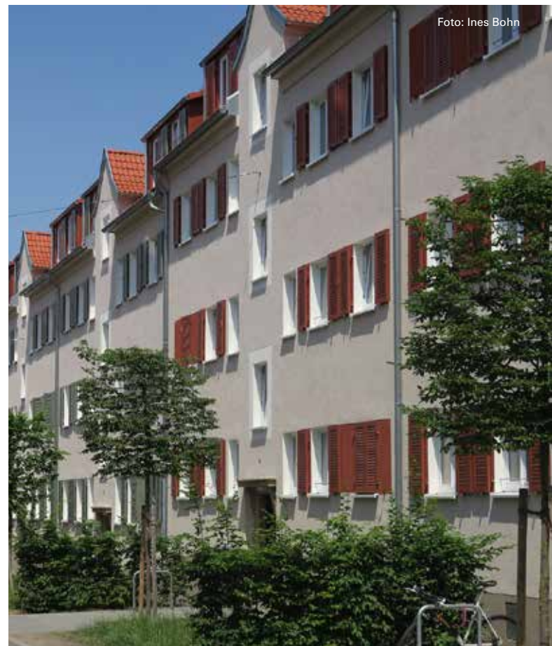
Raitelsbergsiedlung im Stil des traditionellen Bauens des 20. Jahrhunderts, Stuttgart von 1926-1928 nach der Sanierung.
