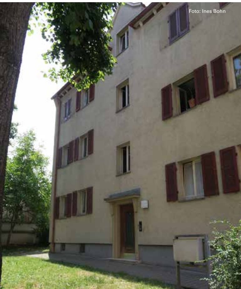
Raitelsbergsiedlung im Stil des traditionellen Bauens des 20. Jahrhunderts, Stuttgart von 1926-1928 vor der Sanierung.
