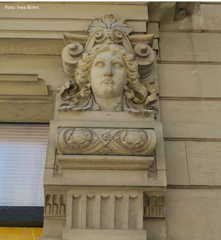
Fassadendetail an einem Wohngebäude aus dem 19. Jahrhundert, Alexanderstraße, Stuttgart.
